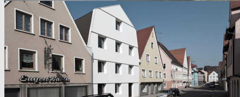
Sanierung / Umnutzung / Neubau
